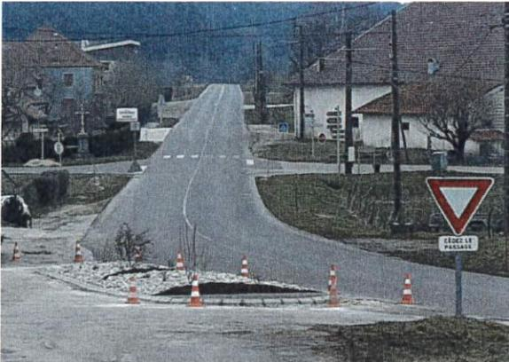
Un aménagement a été réalisé par l'entreprise CCEV d'Arc-Sous-Montenot, pour casser la vitesse et empêcher les véhicules de doubler en passant par le bas de la rue des Tours.
